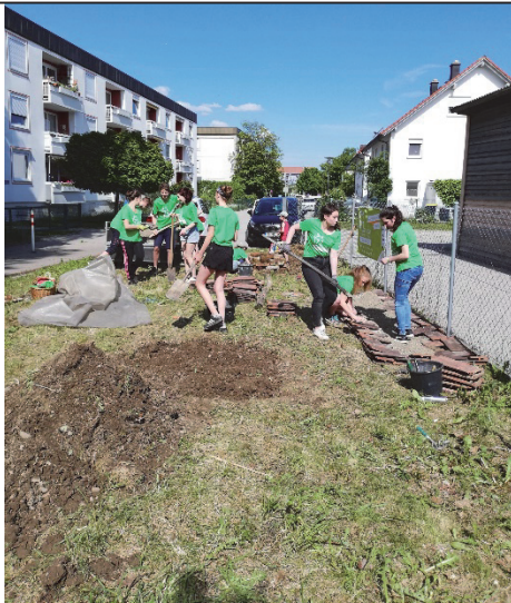
Die ersten Erdarbeiten
